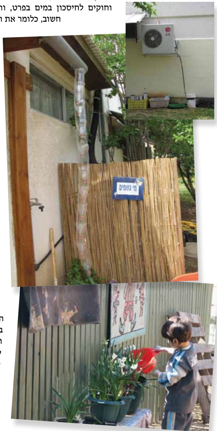
בתמונות (מלמעלה למטה): (1) המים יוצאים מהמזגן ונאספים בכלים; (2) מרזב מבקבוקים מוביל למכל; (3) השקיית הגינה במים שנאספו במכל שעל הגג
